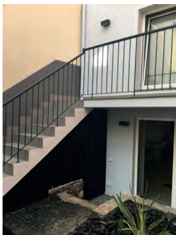
Escadas de acesso no logradouro
