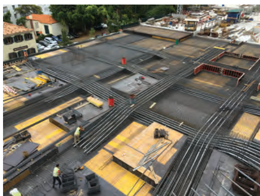
Laje do solário/ teto do cais descarga - cofragem, armaduras e pré-esforço
