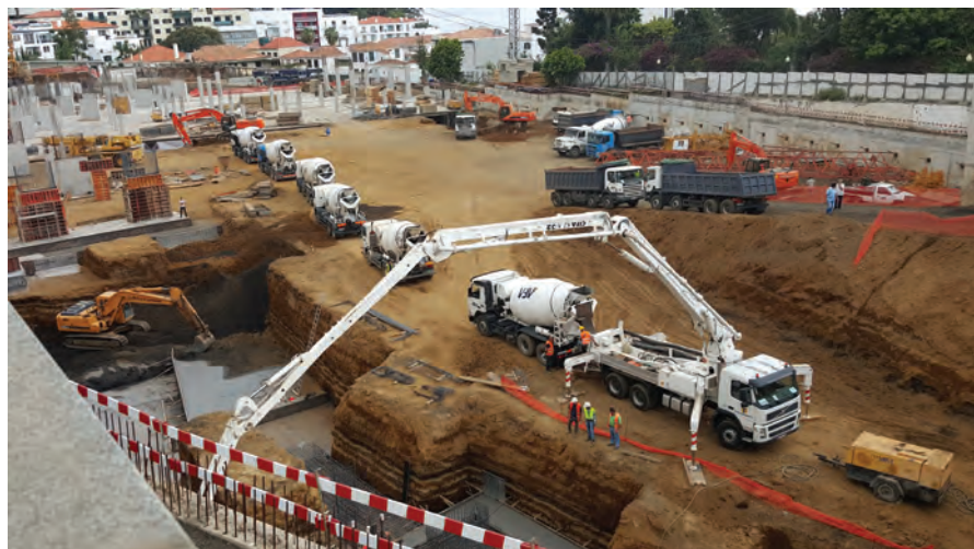
▲ Grandes betonagens das fundações
