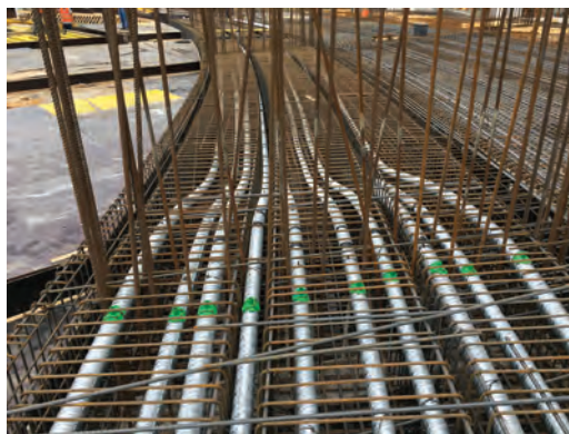
Banda pré-esforçada - bainhas e pontos de purga
