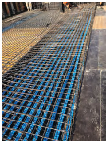
▼ Lajes pré-esforçadas com monocordões
