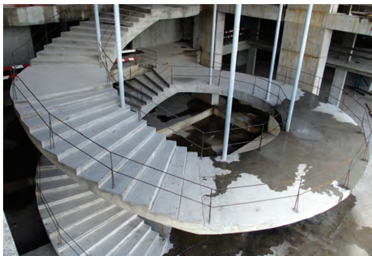
▼ Lajes pré-esforçadas com monocordões
