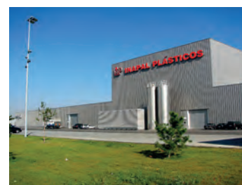
INAPAL - Complexo Fabril que produz componentes para a VW, constituído por duas unidades designadas por Fábrica da Inapal Plásticos e Inapal Metal, em Palmela, com uma área total de 37 000 e 15 000 m 2 , respetivamente. Desenvolvido com o Arquitecto Francisco Vieira de Campos. Projecto de Instalações Mecânicas
