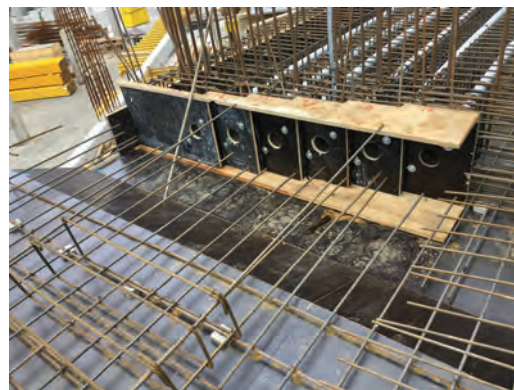
Banda pré-esforçada - cabeças de ancoragem
