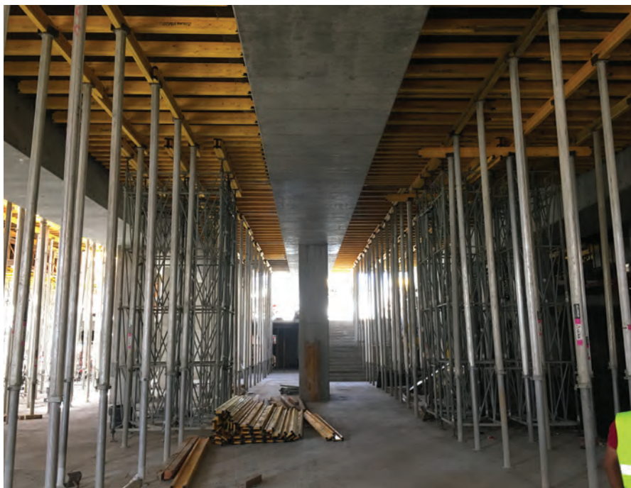
Teto Sala de Congressos - Vão de 25m
