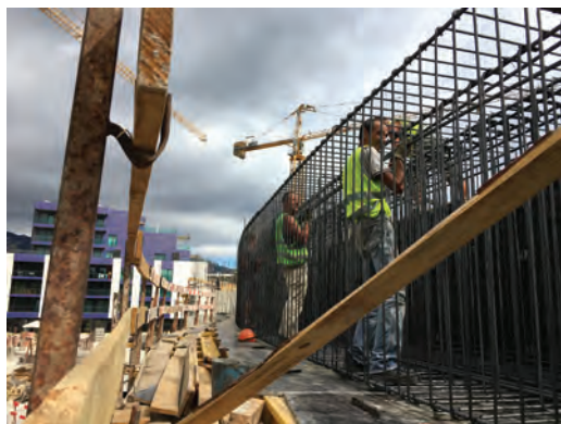
Vigas pré-esforçadas da sala de congressos - altura = 1,80m
