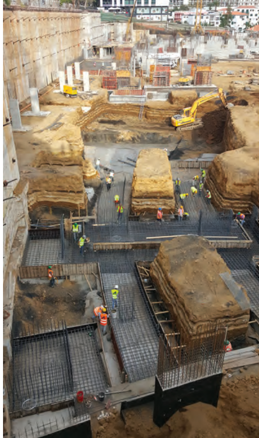
Fundações dos pilares principais - escavação, cofragem e armaduras
