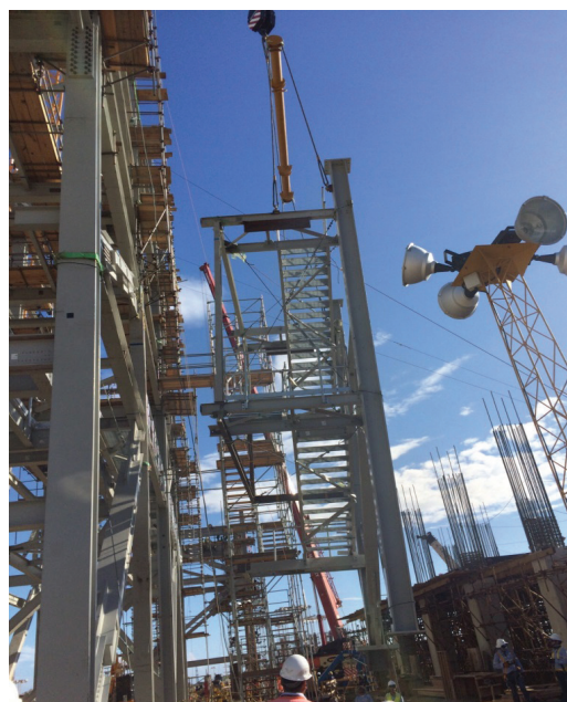
Instalação de um dos seis módulos na obra Etileno XXI
