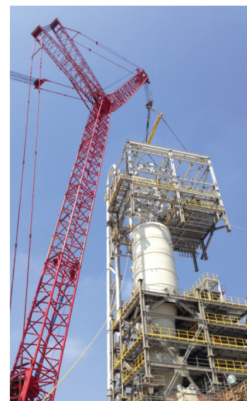
Instalação de um dos seis módulos na obra Etileno XXI
